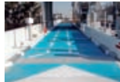
ETC対応型車両重量計設置レーン
