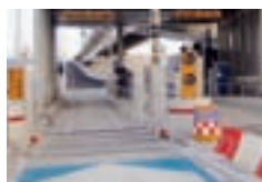
ETC対応型車両重量計設置レーン
